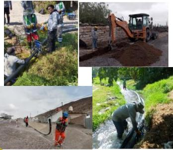
Línea de conducción con tubería HDPE a AA.HH. Virgen del Rosario
