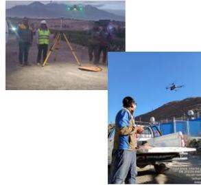
Levantamiento topográfico para replanteo de redes de distribución en AA.HH. Virgen del Rosario
