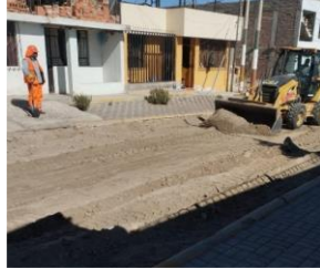
OBRA EN EJECUCIÓN
