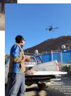
Levantamiento topográfico para replanteo de redes de distribución en AA.HH. Virgen del Rosario
