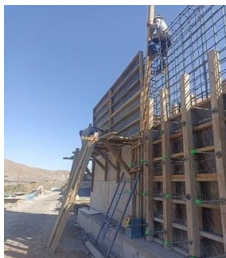
OBRA EN LA ACTUALIDAD
