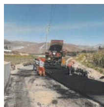
OBRA EN EJECUCIÓN
