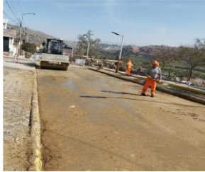
OBRA EN LA ACTUALIDAD
