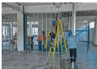
OBRA EN LA ACTUALIDAD
