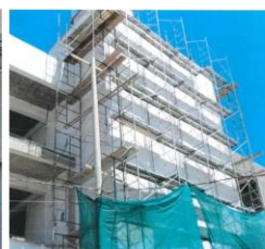
OBRA EN EJECUCIÓN
