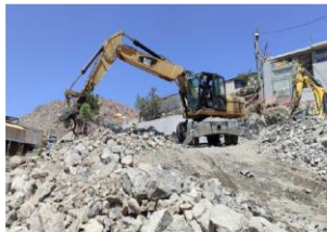
OBRA EN LA ACTUALIDAD
