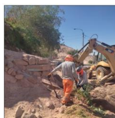
OBRA EN EJECUCIÓN
