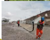
Línea de conducción con tubería HDPE a AA.HH. Virgen del Rosario
