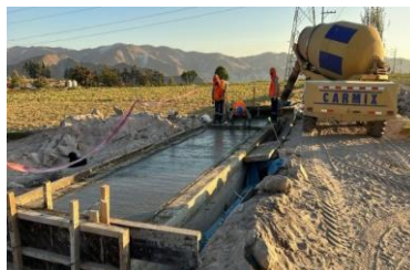
OBRA EN LA ACTUALIDAD
