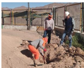
OBRA EN LA ACTUALIDAD
