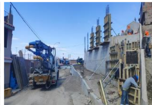
OBRA EN EJECUCIÓN
