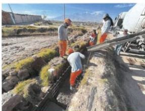
OBRA EN LA ACTUALIDAD
