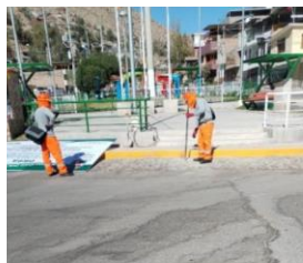
OBRA EN LA ACTUALIDAD
